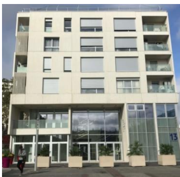
Centre municipal de santé au Chaperon Vert
